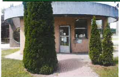
Local chauffeurs Sanitaires/distributeurs
